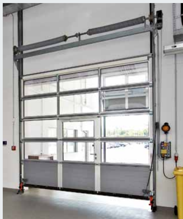
Na vnitřní straně barevných vrat jsou vyztužení vratového křídla a koncové úhelníky lamel dodávány zásadně v šedobílé barvě, RAL 9002. U vrat s integrovanými dveřmi je rám integrovaných dveří na vnitřní straně vytvořen z hliníkových profilů s povrchem E6 / C0 (dříve E6 / EV 1).
