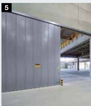
5 Protipožární posuvná vrata
